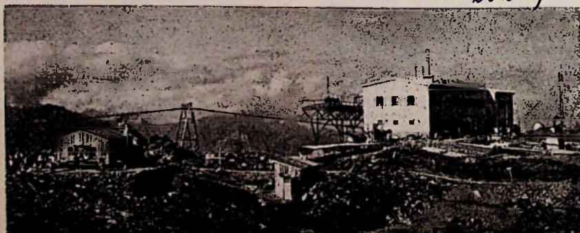
EUROPA'S HOOGSTE TV ZENDER is onlangs geplaatst op de Patscherkofel (2200 m) ten zuiden van Innsbrück in Oostenrijk. De zender werkt in band I; vermogen beeld 3,5 kW, geluid 0,8 kW. Op de foto is men bezig een mast van 50 m hoog op te richten, waaraan de speciale antennes worden bevestigd. Deze stralen de energie van de zender gericht uit naar het gebied van het Inn-dal, het Stubai dal en naar Innsbrück. Zender en antennes werden door Siemens geleverd. Speciale antennes waren nodig om, i.v.m. de moeilijkheden, welke aan TV ontvangst in de Alpen zijn verbonden, in het bijzonder de bewoners van de dalen een goede ontvangst te verzekeren.
